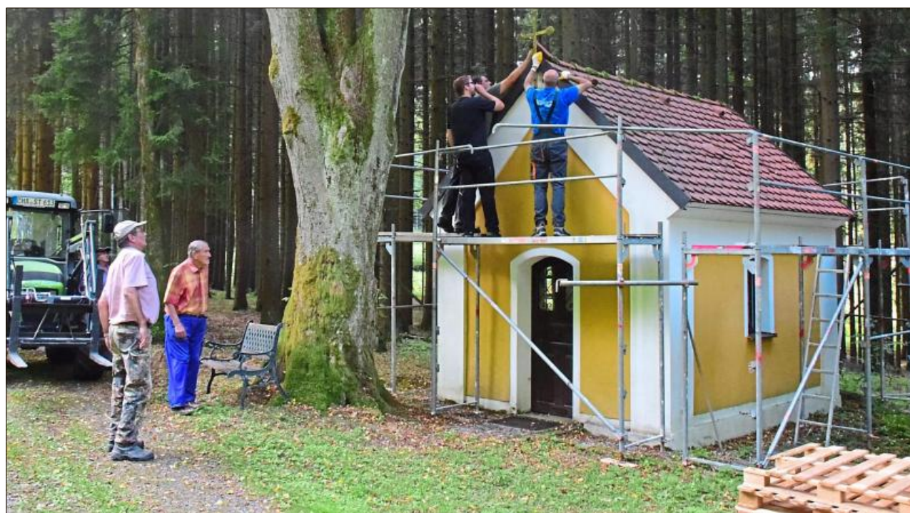
Die KAB RötZ machte sich daran, den Dachstuhl der Pottenhofer Kapelle zu reparieren.
